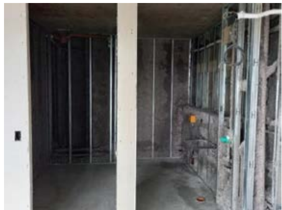
Proyección de celulosa en piso 24°
