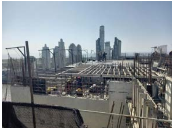
Armado de losa en s/34 sector Rio
