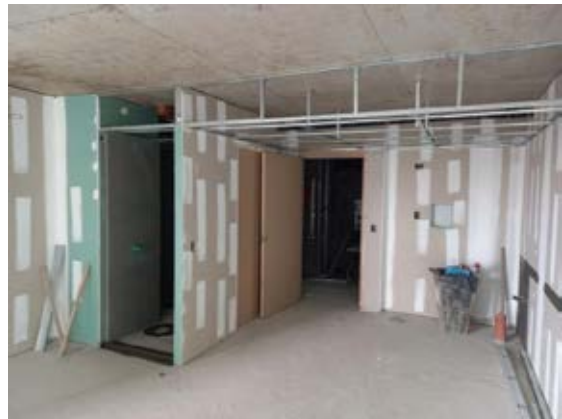
Segunda placa y estructura de cielorraso en piso 20°
