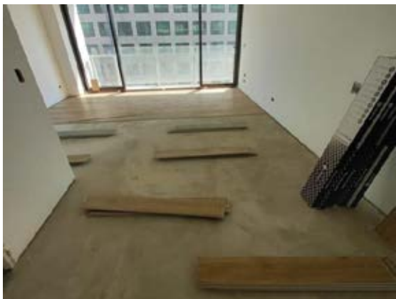
Avance con la colocación de piso vinilo 18°
