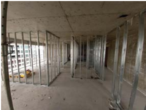
Montaje de la estructura de durlock en piso 28°
